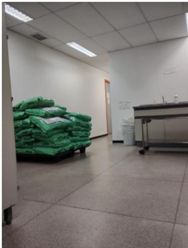
Foto 1 – Piso e Teto da sala 120
