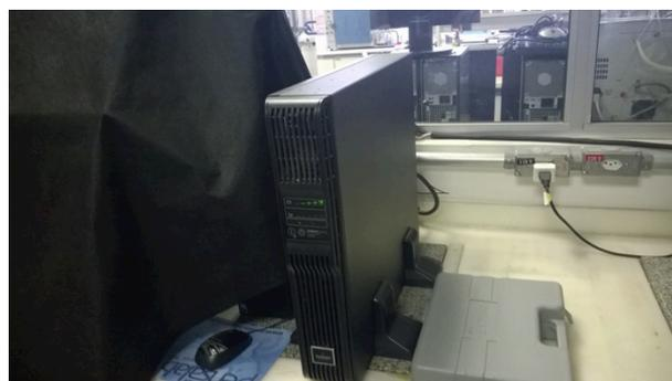
**Figura 1.** Módulos de *no-break* e baterias instalados no laboratório de pesquisa L202 (Bloco B, Campus SA, UFABC).
