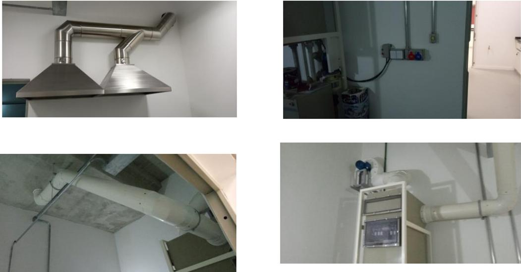
Figura 1. Sistema de exaustão (coifas e acessórios) instalados no laboratório L009.
